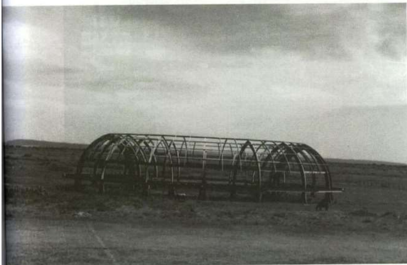
Memorial a Rondon em construção em Mimoso, MT. Foto: Suíse Monteiro Leon Bordest.
