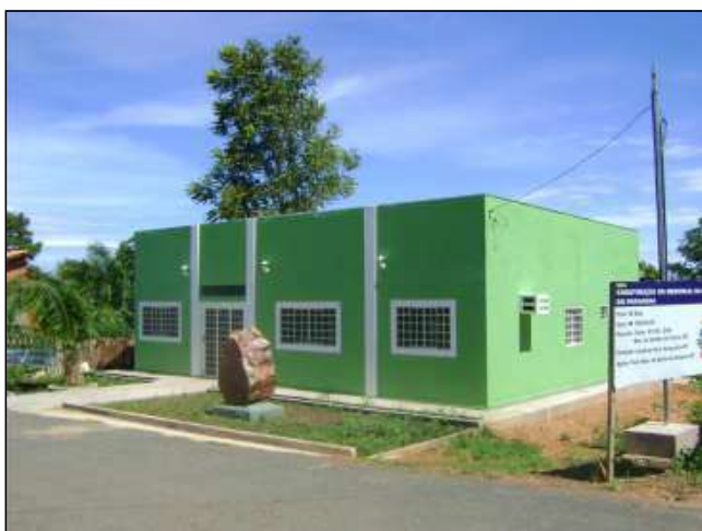
Barão de Melgaço. Construção do Memorial da Guerra do Paraguai. Foto Bordest. 2011.
