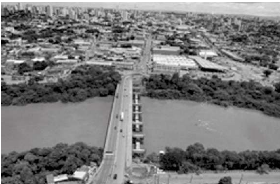
Fig. 2 - Ponte Júlio Müller em fase inicial de ampliação
