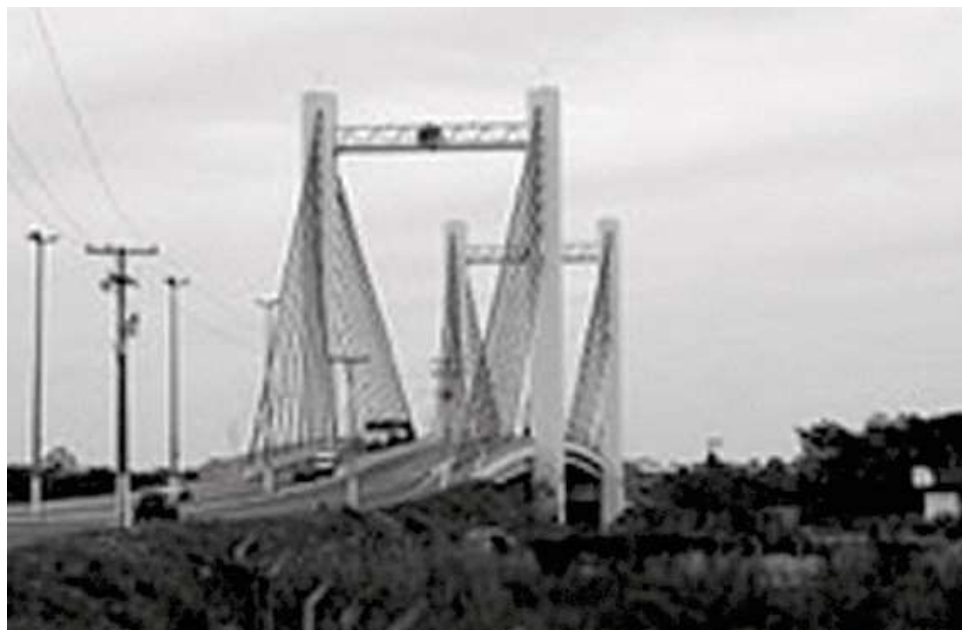
Figura 6 - Ponte Sérgio Motta
