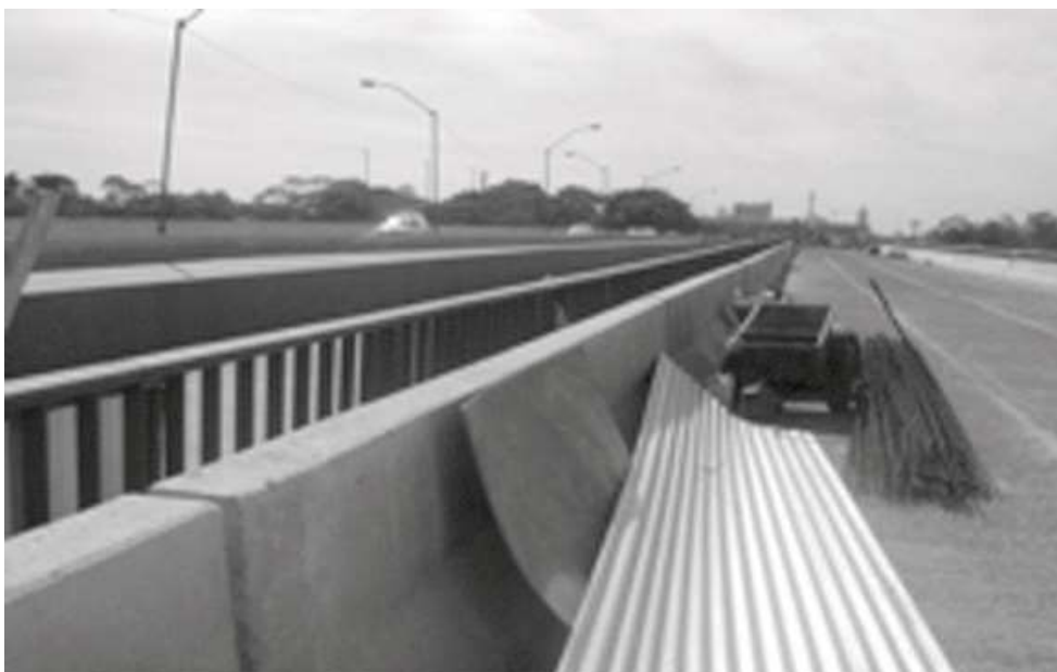
Foto 7 - Ponte Júlio Müller em final de construção no ano de 2014
