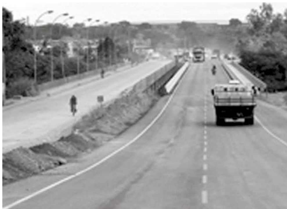
Fig. 5 - Ponte Mário Andreazza
