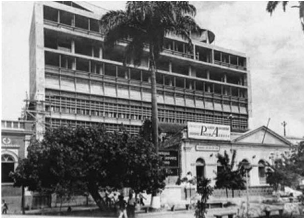
Fig. 9: A fachada do antigo Palácio Alencastro serve de tapume para a obra de construção do novo Palácio Alencastro
