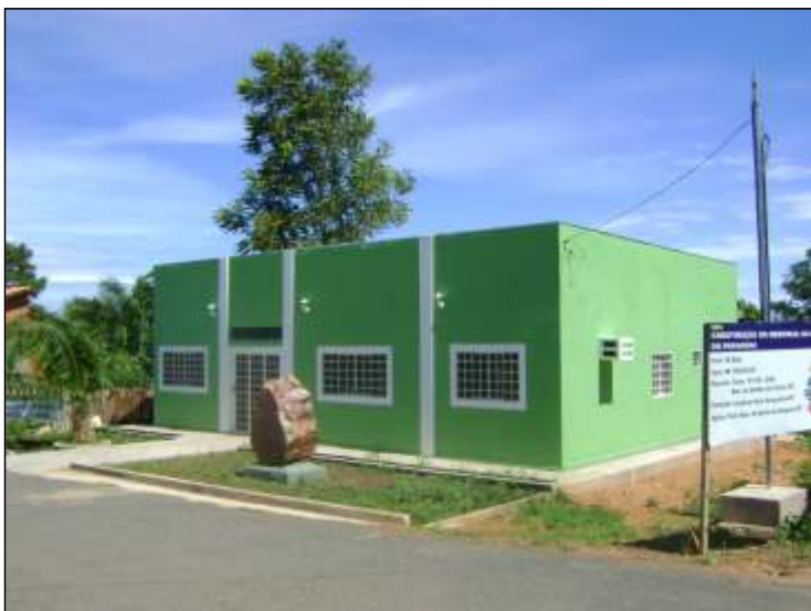
Barão de Melgaço. Construção do Memorial da Guerra do Paraguai. Foto Bordest. 2011.
